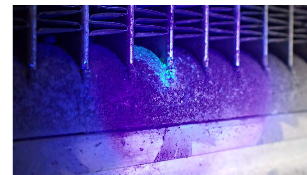
Fig. 2 Perforation par la rouille sur le condenseur
