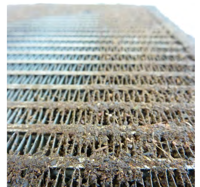
Fig. 2 Évaporateur obstrué
